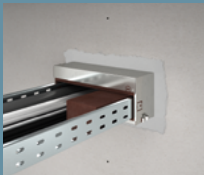
Zugeschnittenen Einlageblock in die größeren Leerräume einbringen
