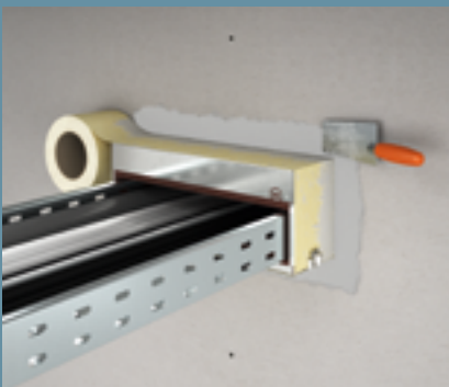
Abkleben und sauberes Einmörteln der Box
